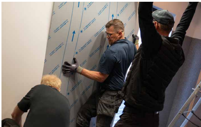
► Gummi, Oddgeir og Styrmir koma upp stálklæðningu í nýju eldhúsi. MYND: VÍKINGUR
